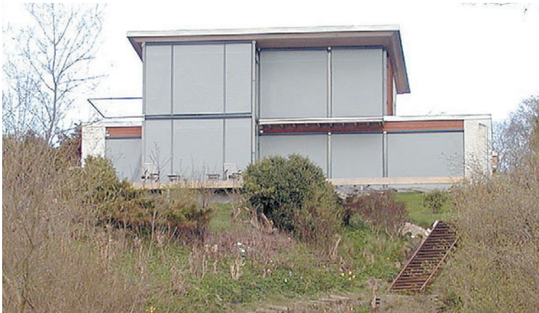
Det skæmmende byggeri på Birkevej 13 set ude fra Furesøen
