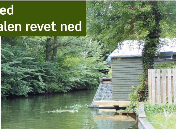
Det skæmmende og ulovlige skur, før det blev revet ned
