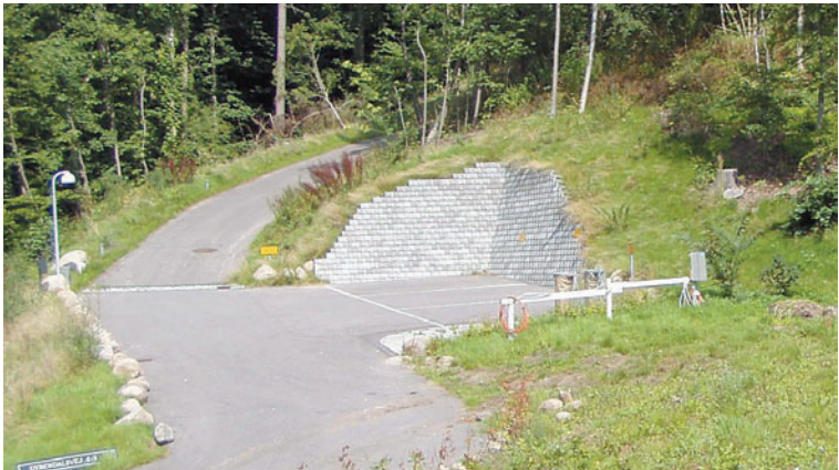
Den smukke skovbevoksede skrænt ved Dybendalsvej/Lundtoftevej er blevet spoleret af vej og P-pladser
