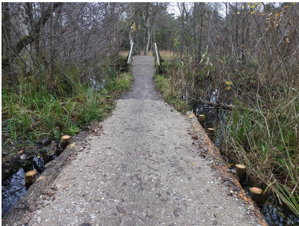
Figur 9-2 Foto fra besigtigelse i Lyngby Åmose d. 5/11-2019, læg mærke til forstærkende stammer, wire og pæle langs med stien, Foto Anna Tauby-Theill, COWI.
