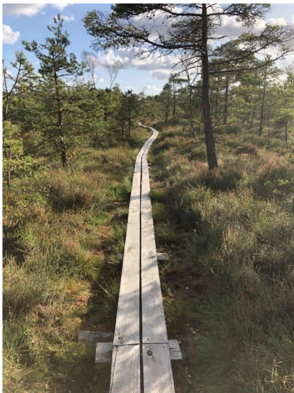
Figur 9-12 Eksempel på simpel boardwalk i udkant af en højmose i Sverige, Foto Anna Tauby-Theill, COWI
