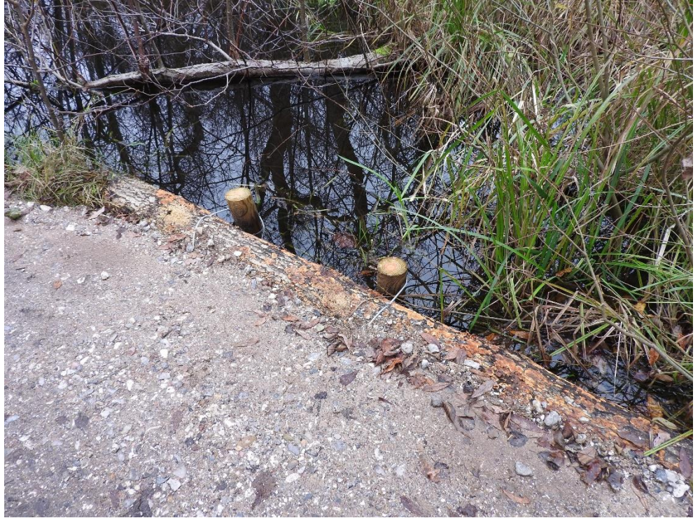
Figur 2-4 Forstærkning af grussti med egestammer og thujapæle. Der bindes wire omkring stamme og pæl, Foto Anna Tauby-Theill, COWI.
