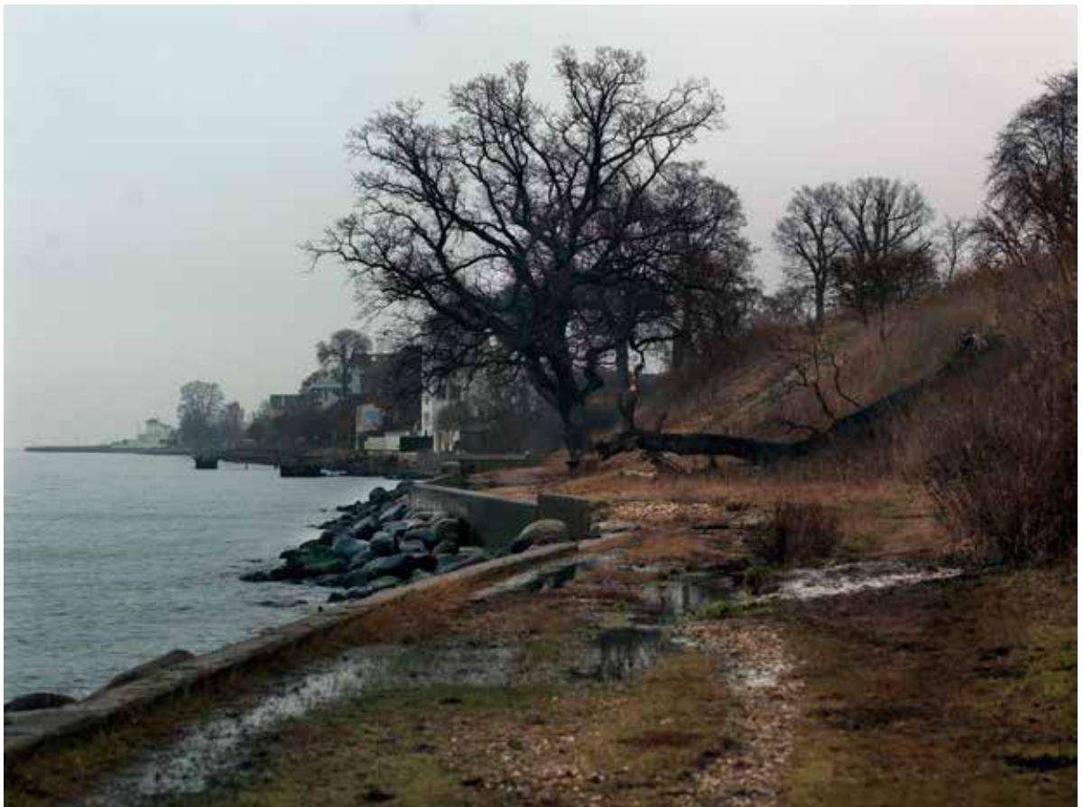
Foto fra opgaveområdet ved opstart i 2014
