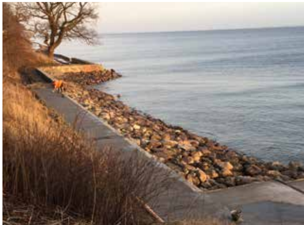
Renovering af kyststi, som tåler oversvømmelse
