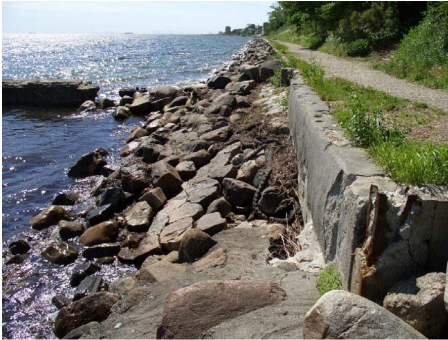
Figur 15: Betonmur fra station 645 til 653 (set mod syd).
