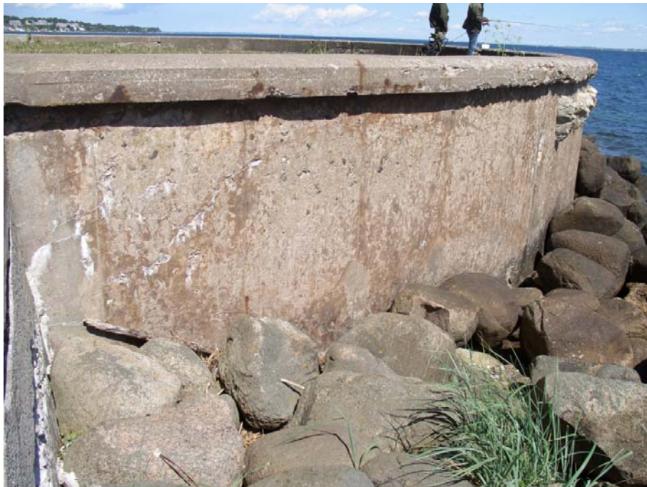
Figur 22: Udsigtsplatformen ved station 1030 – 1050.
