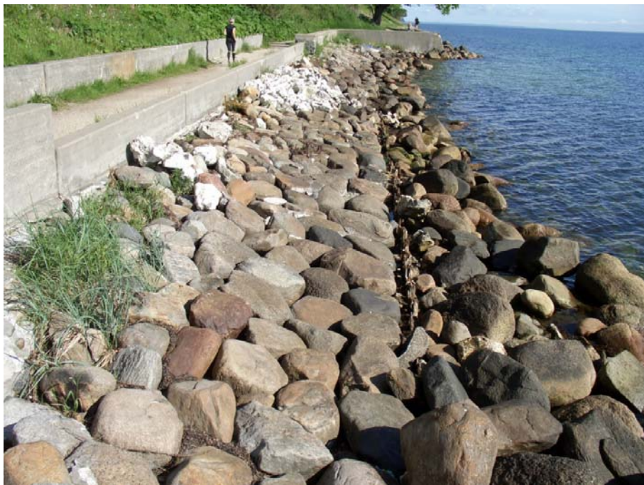
Figur 4: Oversigtsbillede af station 68 - 134.
