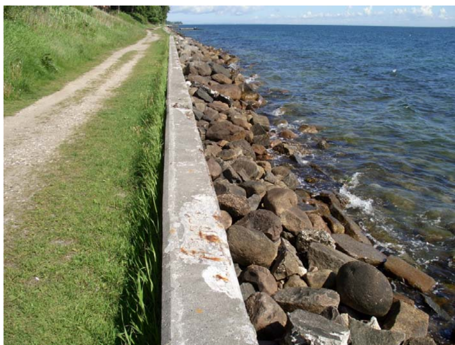
Figur 10: Oversigtsbillede af station 353 – 585.
