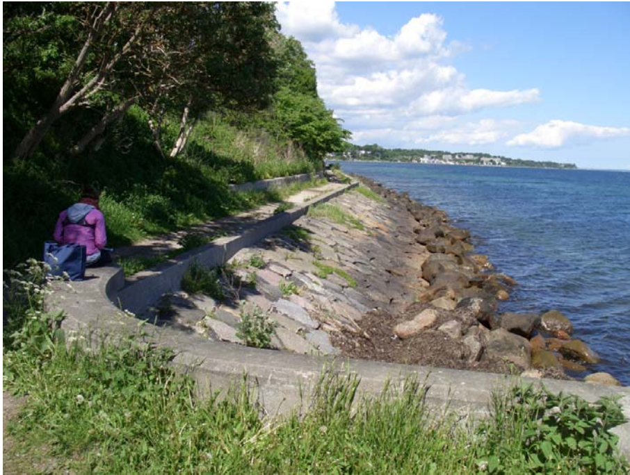
Figur 23: Oversigtsbillede af station 1050 – 1200 set fra udsigtsplatformen.
