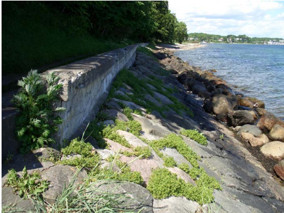
Figur 25: Oversigtsbillede af station 1200 – 1320.
