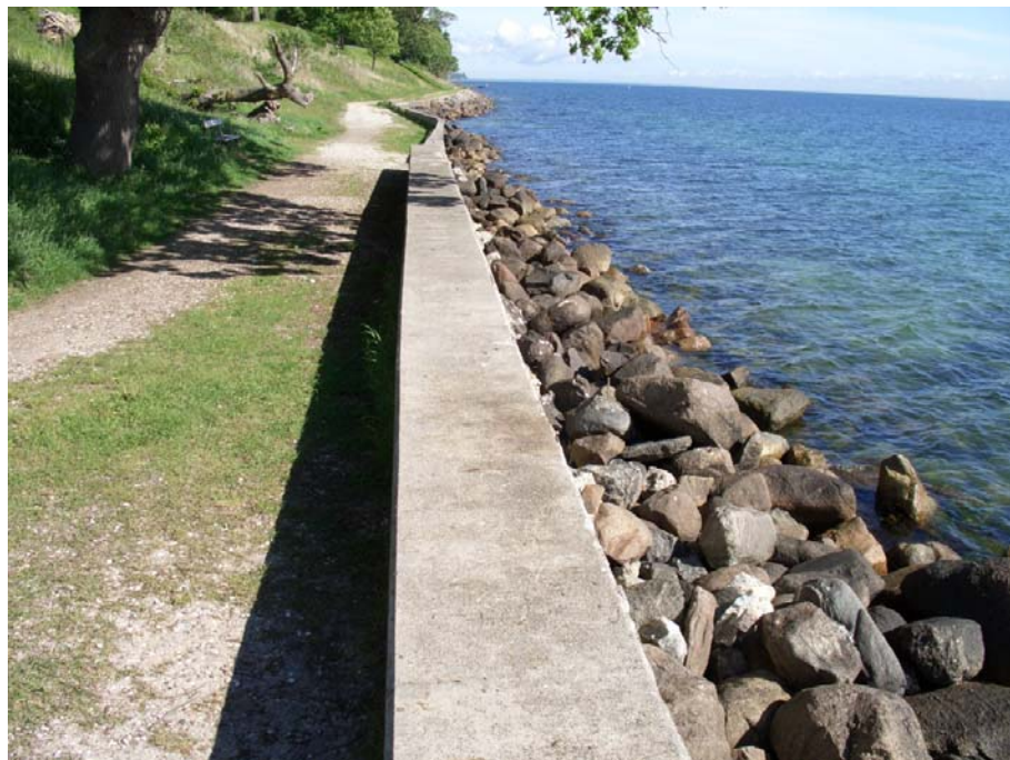
Figur 6: Oversigtsbillede af station 134 – 242.
