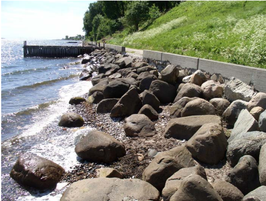
Figur 19: Oversigtsbillede af station 850 – 900 (set mod syd).
