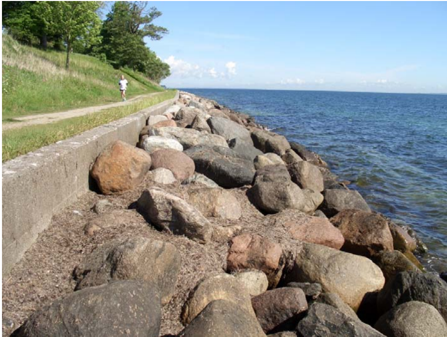
Figur 8: Oversigtsbillede af station 242 – 353.
