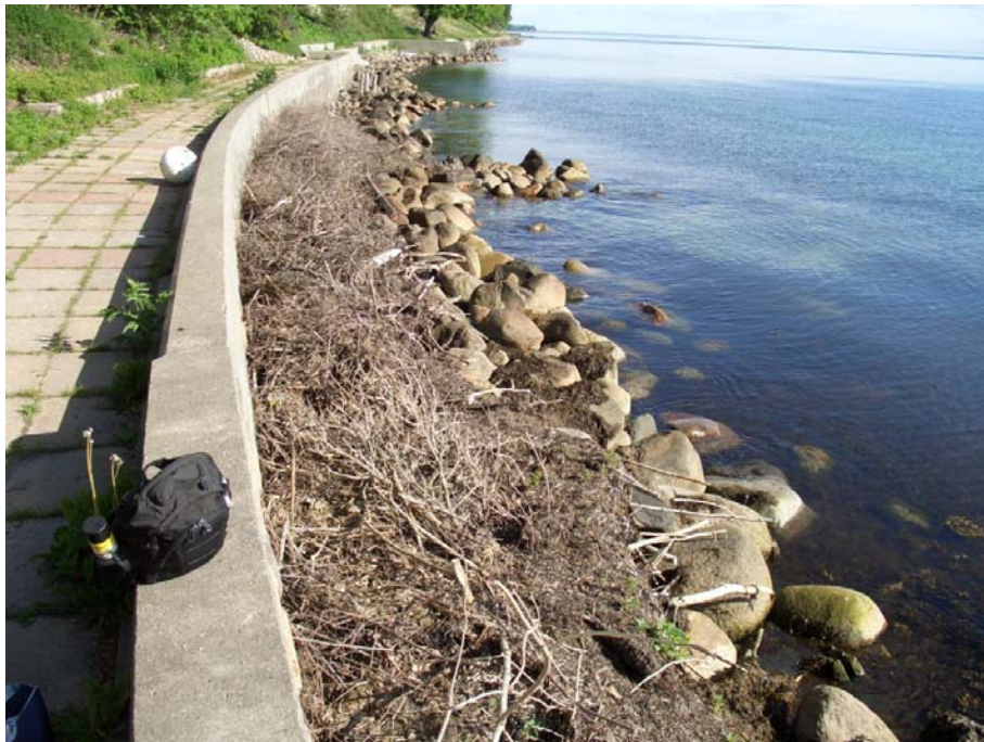
Figur 3: Oversigtsbillede af station 0 – 68.
